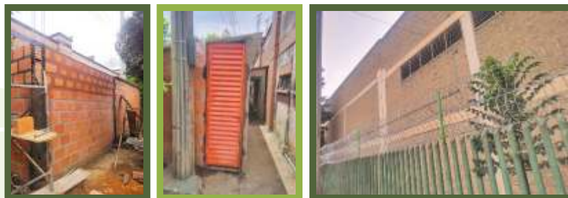
Fotos. Mejoras instalaciones físicas de la subestación eléctrica de la EDS; refuerzo al lindero oriental de la bodega No. 15 y acceso al norte de la EDS.
