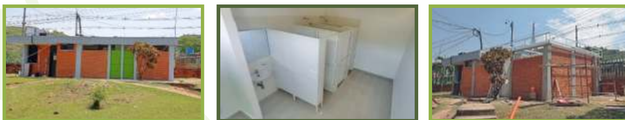
Fotos. Obra terminada de la batería de baños, junto a la oficina de la báscula externa.
