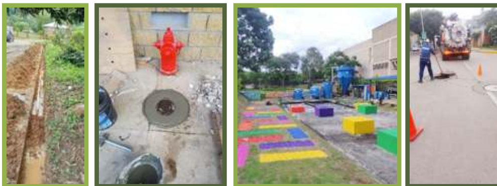
Fotos. Mantenimiento a red de acueducto, lavado de tanques subterráneos para agua potable, mantenimiento externo a la PTAR1, dragado de alcantarillado.
