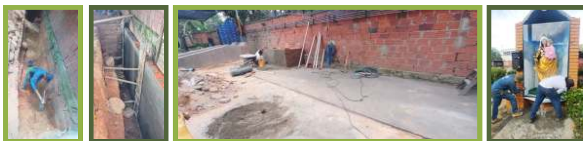
Fotos. Reparación muro lindero costado sur, junto al lavadero de automóviles en la bodega No.12; arreglos a la gruta, en Centroabastos.
