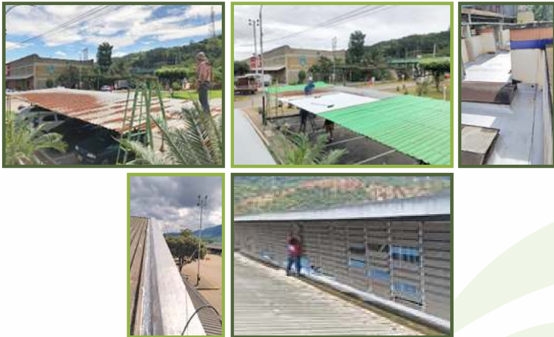
Fotos. Actividades antes y después con cambio de lámina del arreglo del techo del parqueadero oriental del edificio administrativo; impermeabilización placa edificio de Garcillantas en la EDS; arreglo de viga culata cambio de vidrios en ventanales de las bodegas comunales.
