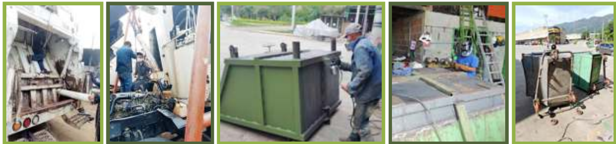
Fotos: Arreglo a caja compactadora de residuos sólidos; arreglos varios a cajas de almacenamiento temporal de residuos sólidos.
