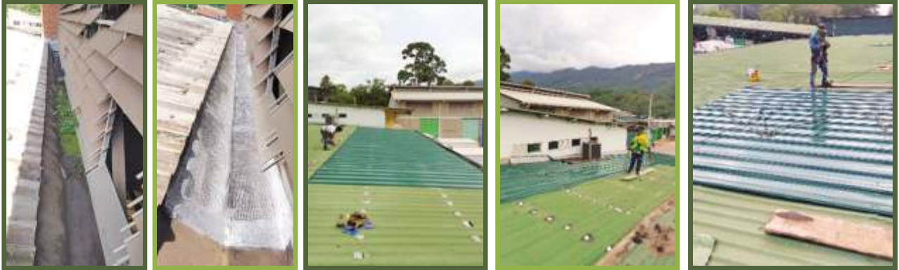
Fotos. Antes y después del arreglo de canales metálicos de las bodegas; cambio de tejas metálicas en la bodega No. 12 y bodega No. 10.
