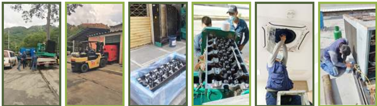
Fotos: Reubicación de plantas generadoras de energía: de la bodega 8 hacia la bodega 14 y la planta del edificio bicentenario hacia la bodega No. 8; arreglo con cambio de culata de la planta de 500 kw reubicada en la subestación principal; Mantenimiento a las unidades de aire acondicionado.
