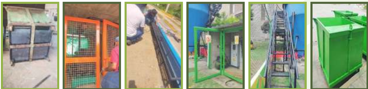
Fotos. Mantenimiento a la carpintería metálica, cajas para residuos sólidos, puertas, barandas Ptar1.
