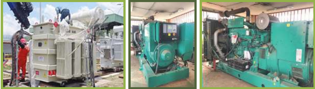
Fotos. Fotos del montaje del transformador de 2 MVA 34,5/13,2 KV y de la planta generadora de energía de 800 KW.
