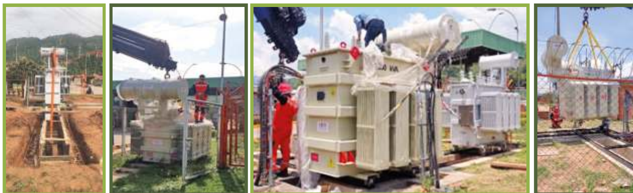
Fotos. Obras civiles y suministro y montaje del nuevo transformador de 2.0 MVA a 35,5/13.2 kv.
