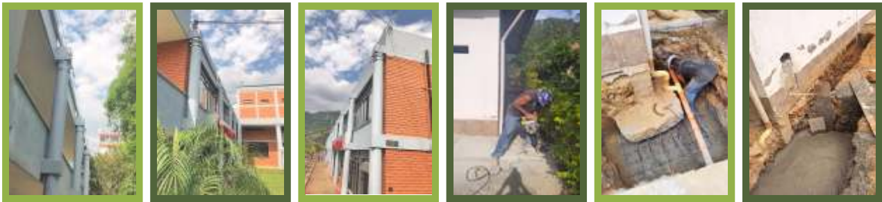
Fotos. Líneas de vida en el edif. Administración; Obras para arreglo cimentación de la batería de baños en la Fundación Semillas de Ilusión.
