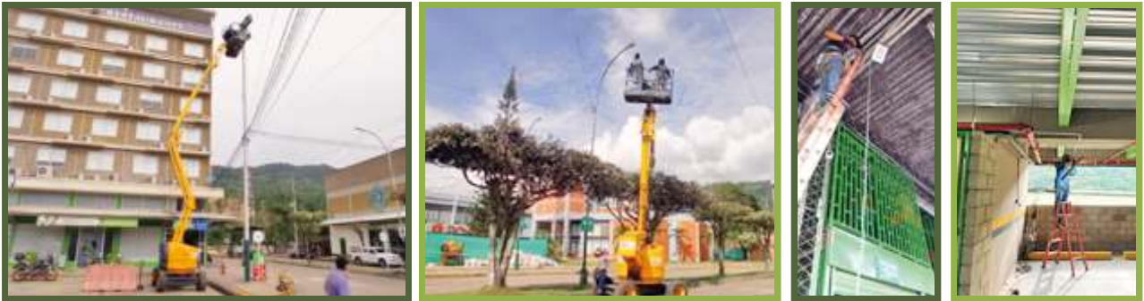
Fotos. Mantenimiento de lámparas altas dentro de las bodegas comunales y alumbrado público externo, actualización a lámparas leds.
