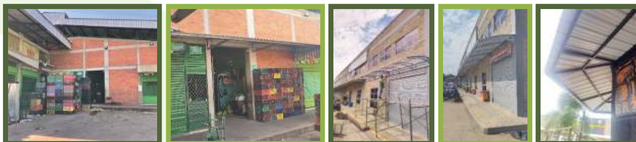
Fotos. Construcción de aleros en estructura metálica, sobre andenes, en la bodega No. 9, locales de la EDS y esquina norte de la bodega No.14.
