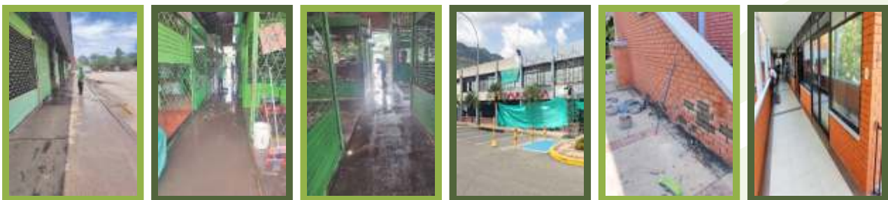
Fotos. Lavado de pisos de las bodegas y arreglo y pintura de la fachada del edificio administrativo de Centroabastos.
