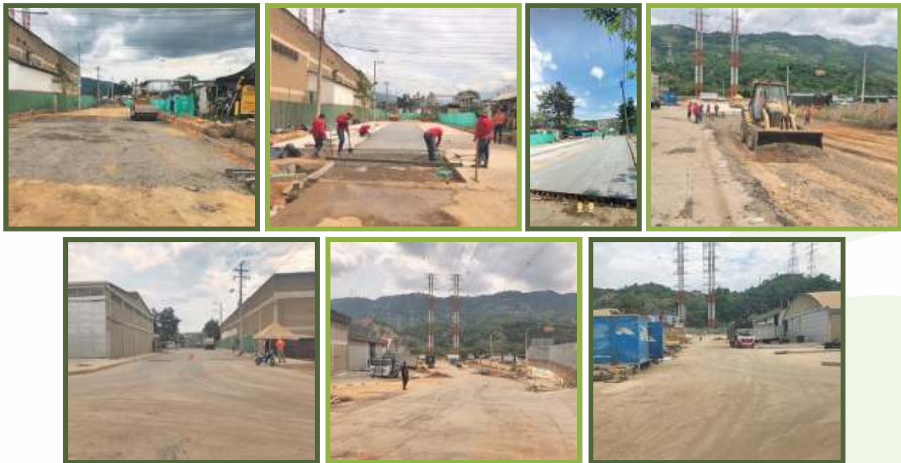
Fotos: Ejecución de la obra construcción de vía en el costado norte de la EDS.
