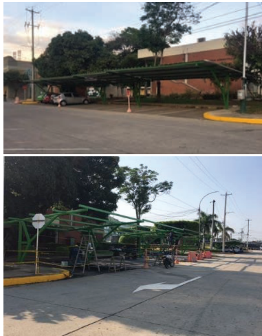
Imagen. Instalación de cubierta a parqueadero del costado occidental al edif. de administración.
