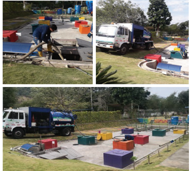
Imagen: Equipo Vector realizando limpieza tanques de sedimentación.
