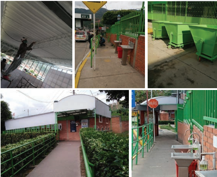
Imagen. Acondicionamiento punto de atención médica prioritaria y arreglo de pasamanos entrada peatonal, compra de baldes metálicos para góndolas, adecuación de cubiertas en los accesos peatonales para control de entrada ante la pandemia del Coronavirus COVID-19.
