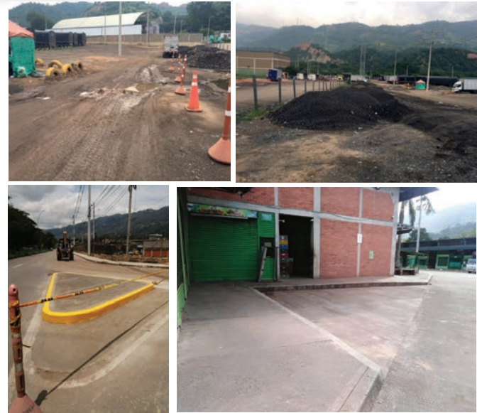
Imagen.. Mejoramiento acceso vehicular lote norte, obras acceso externo lote norte, construcción de zona de parqueo en el costado norte de la bodega N.9
