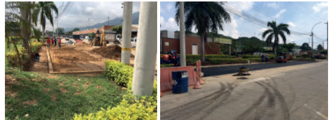
Imagen. Construcción de parqueadero en el costado occidental del edif. de servicios complementarios
