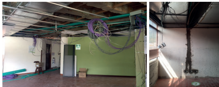
Imagen. Redes antiguas eléctricas y de datos que se reorganizaron y actualizaron, instalación de puntos eléctricos, montaje de piso en PVC.
