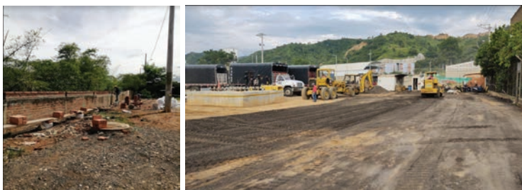
Imagen. Punto de atención médica prioritaria, reconstrucción de muro con concertina en el lote norte a la EDS, reconstrucción de tramo de muro costado sur de la bodega N.16, mantenimiento al piso lote norte, extendida de material residuo de asfalto, domo ingreso barrio. Galán por instalación de cámara con control de temperatura.
