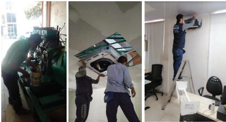
Imagen. Mantenimiento a planta generadora de energía, instalación y mantenimiento de unidades de aire acondicionado.
