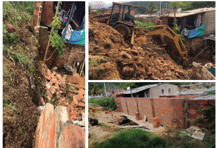
Imagen. Daños sucedidos en el mes de abril en donde se ve la afectación y su reparación. Abril de 2020
