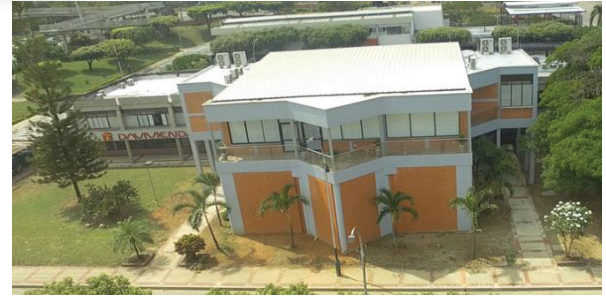
Imagen. Vista aérea exterior de las nuevas oficinas de sala de juntas y gerencia general. Diciembre de 2020
