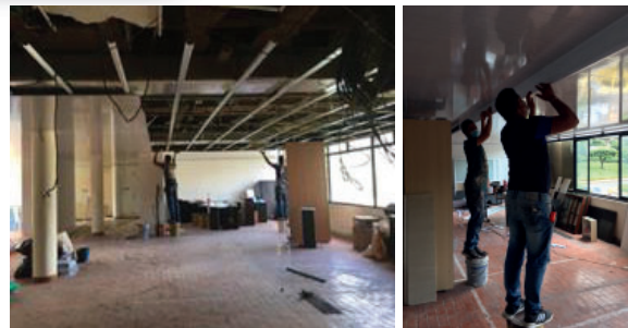
Imagen. Desmonte de oficinas antiguas, montaje de cielo raso en PVC. Diciembre de 2020
