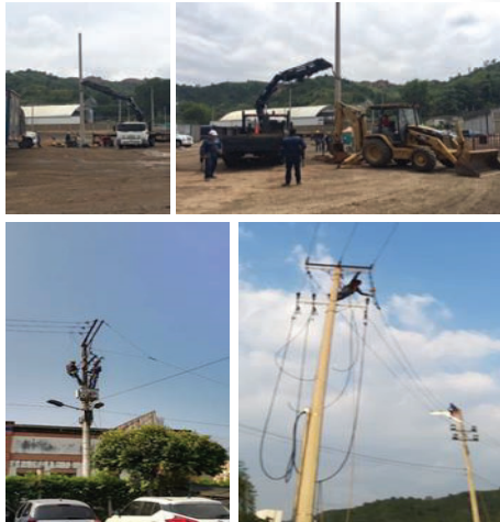
Imagen. Instalación de lámparas leds, reubicación de la red a 13. KV de la zona de servidumbre, tendido ampliación de la red a 13.2 KV en el Lote norte a la EDS.
