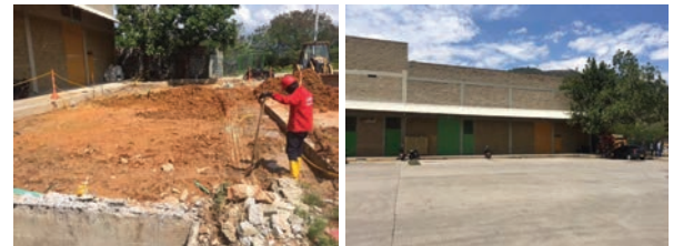
Imagen. Construcción de parqueadero en el costado norte de la bodega N.13.
