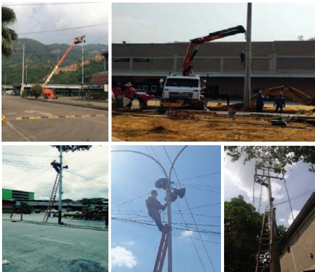
Imagen. Cambio red telefónica EDS, reubicación de poste de concreto en la bodega No. 14, arreglo corto circuito por daño pararrayos y cañuela en la bodega N.16, mantenimiento al sistema de perifoneo
