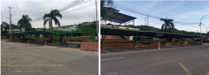
Imagen. Instalación de cubierta a parqueadero del costado occidental al edif. de servicios complementarios
