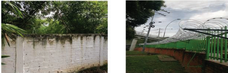
Fotos Instalación de concertinas que refuerzan la seguridad física.
