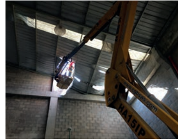
Imagen. Daños sucedidos en el mes de febrero 2020
