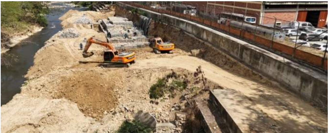
Fotos proceso de reconstrucción del muro de protección en gaviones.
