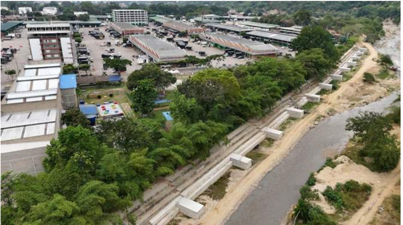
Fotos. Estado del muro de gaviones averiado por las lluvias, proceso de reconstrucción antes y después de la intervención
